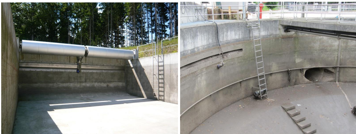
Abbildung 3: Regenbecken in Rechteck- (links) und Rundbauweise (rechts)
