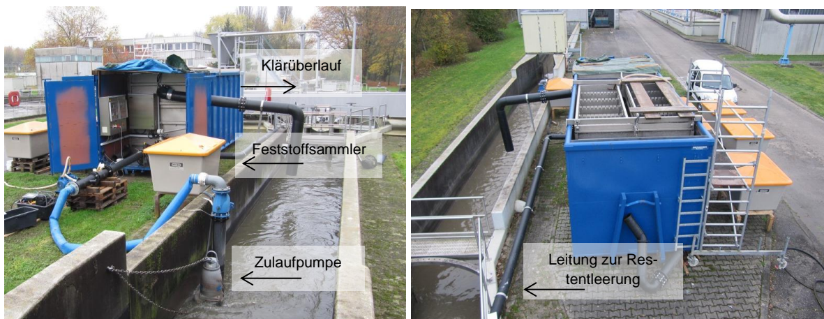
Abbildung 50: Versuchsstand am Standort Rastatt (Links: Blick auf den Zulauf; Rechts: Blick vom Ablauf)
