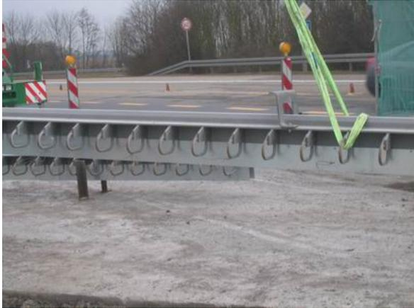
Abb: Einsetzen der neuen Üko
