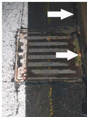
Abb: Dichtmasse in den Fugen
