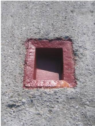
Abb: Abwasserschacht, sandgestrahlt und mit Rostschutz versehen
