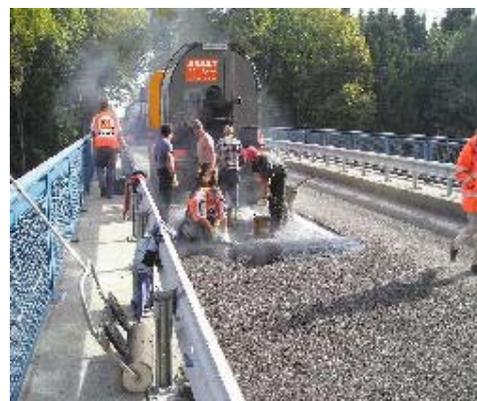
Abb: Gussasphalteinbau von Hand
