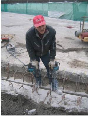
Abb: Restarbeiten von Hand ( Üko-Ausbau )
