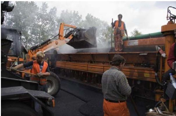
Abb: Maschineller Gussasphalteinbau
