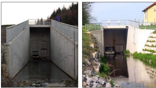
ungesteuerte Durchlassbauwerke von HRB im Hauptschluss (Fotos: Seidel)
