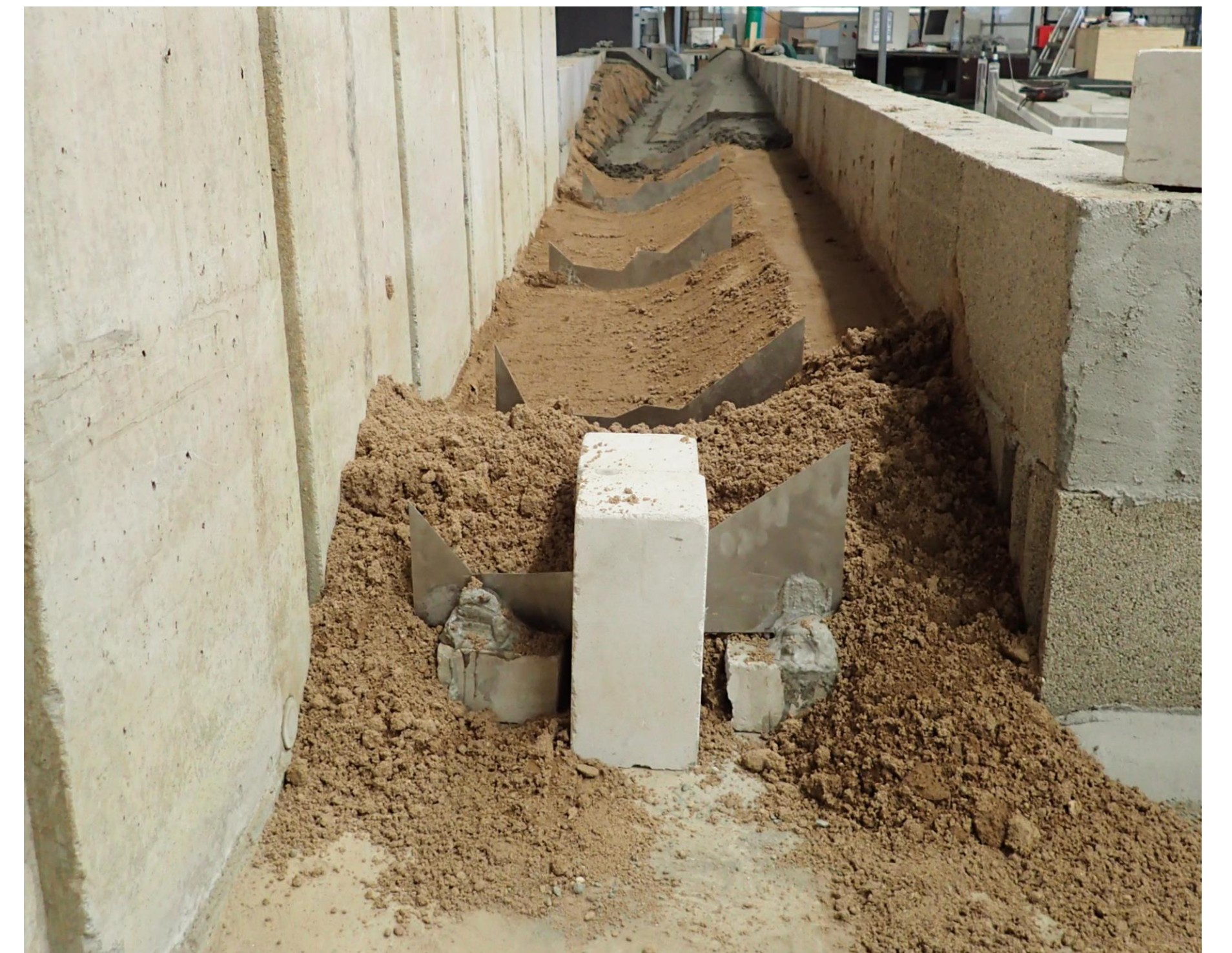
Nivellieren, Sanden und Betonieren der Profile; Quelle: IWG/KIT
