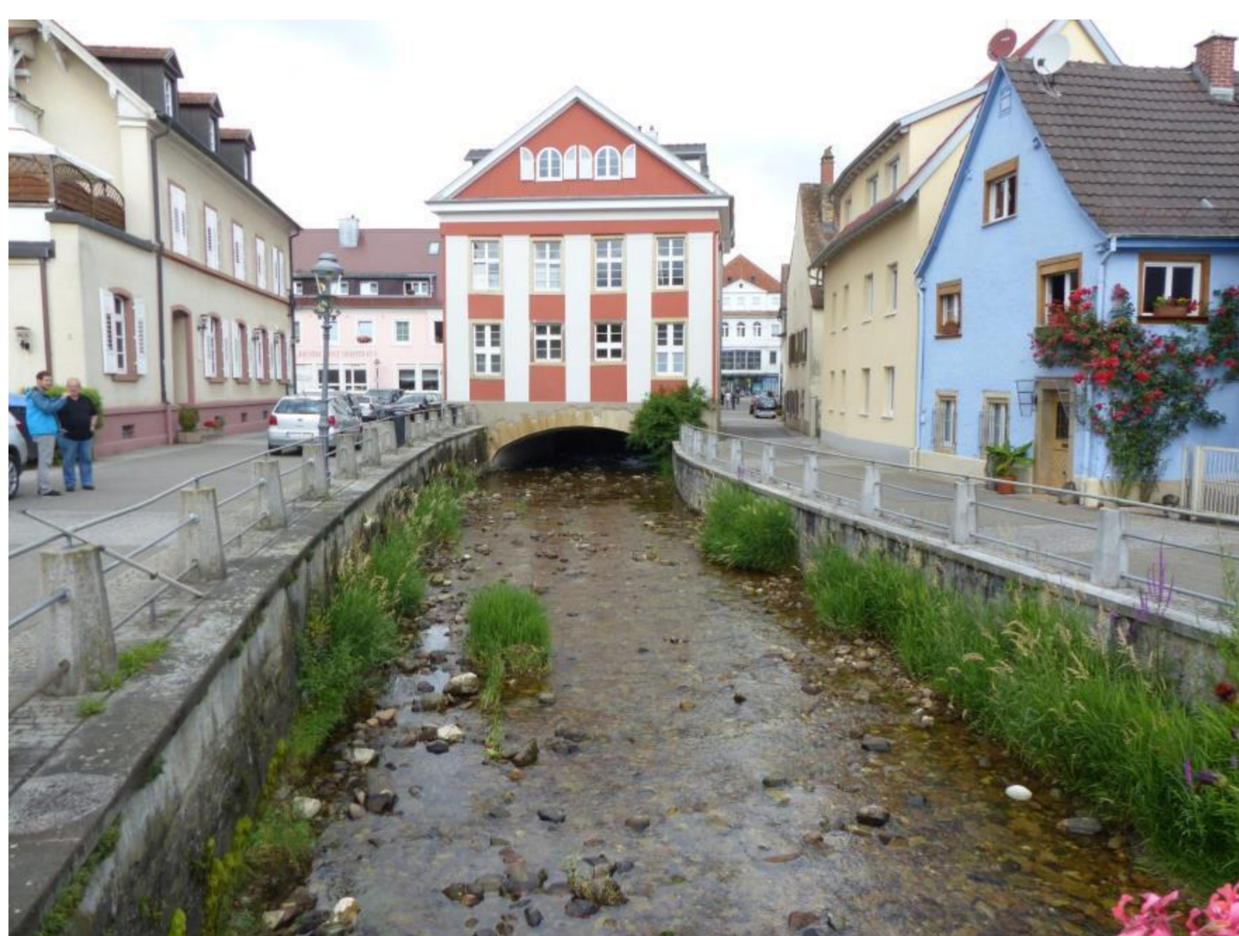
Querbauwerk – „Alte Musikschule“
