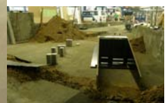
Einbau des Bauwerks (Blick in Richtung Unterstrom)
