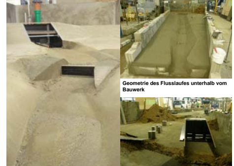
Blick aus Unterstrom auf das Wehr und das Auslassbauwerk
