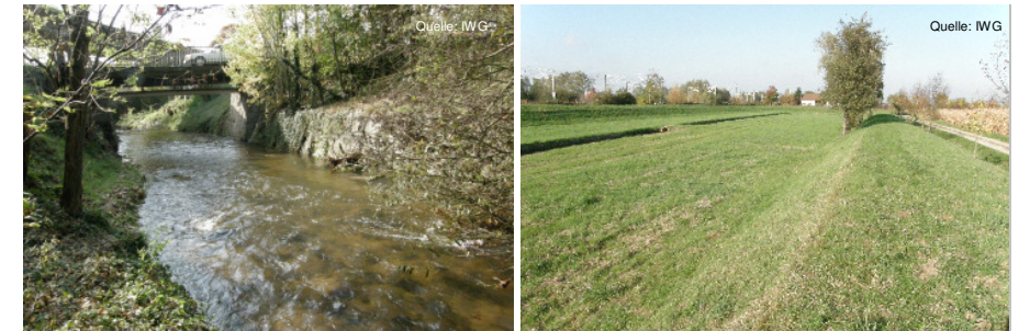
Stelle des geplanten Abzweigbauwerks an der Bühlot
